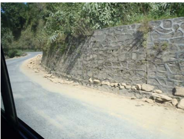
▲現地で多く見かける練石積擁壁の様子 日本の練石積と異なり、石材が中へ押し込まれ ているような造りで、メロンの皮の様である。 余った石材はそのまま放置している模様。
