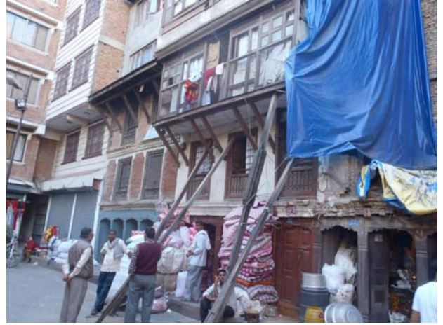
▲前傾状態の建物を支える柱
