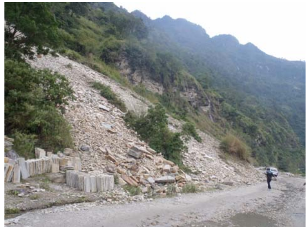
▲地すべり被害箇所
