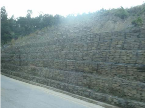
▲災害対策が施された箇所の様子 綺麗に蛇籠が積まれているが、残斜面は未対策 であり、今後降雨による浸食が懸念される。
