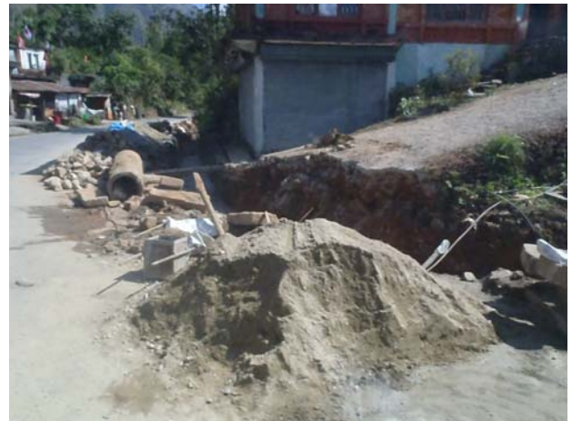
▲水路工事現場 安全対策は皆無
