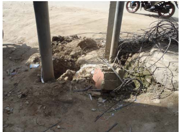
▲電柱工事完成の様子 余った電線は放置されている
