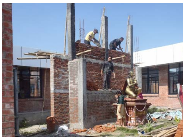
▲空港モニュメントの施工状況
