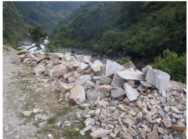
▲被災箇所から選別されている石材
