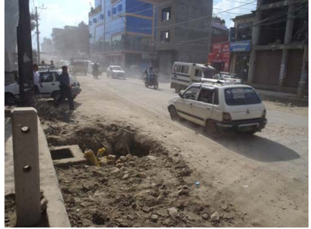
▲土埃と水路工事完成の様子
